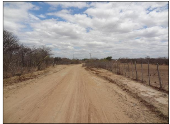
Foto 2 - Estrada vicinal que acessa a área do projeto (UTM 355136/ 9530432)
